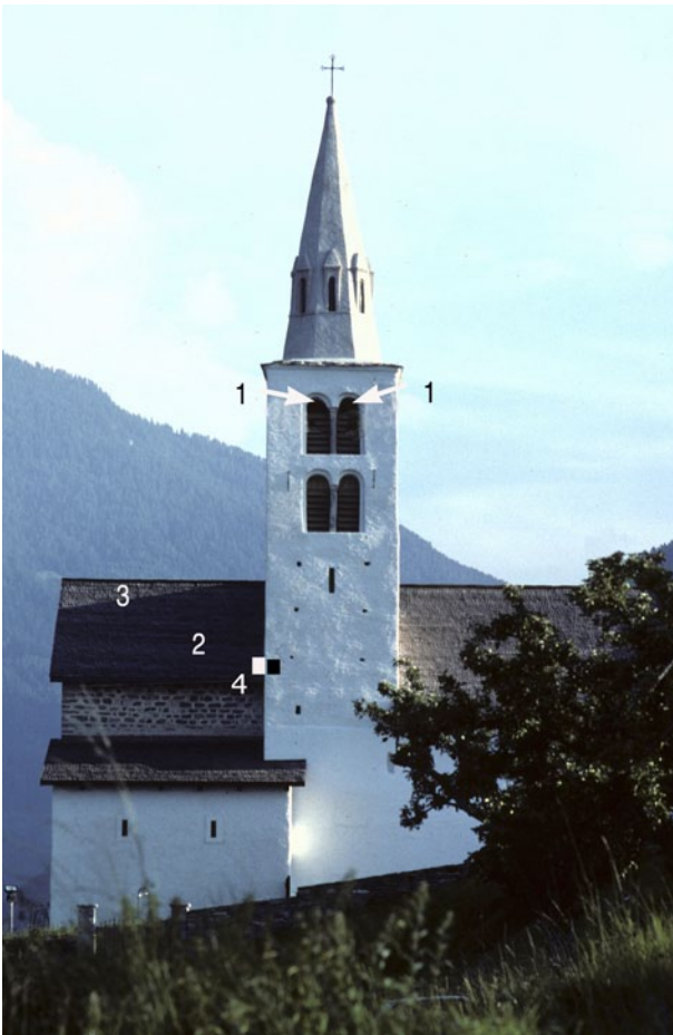
Fig. 4: L'église St-Sylve après la rénovation (vue du nord). 1. Entrées pour les rhinolophes. 2. Combles du chœur. 3. Nouvel emplacement principal de la colonie de grands rhinolophes dans la sous-pente. 4. Nouveau tunnel d'accès entre clocher et combles. (Photo Raphaël Arlettaz)
